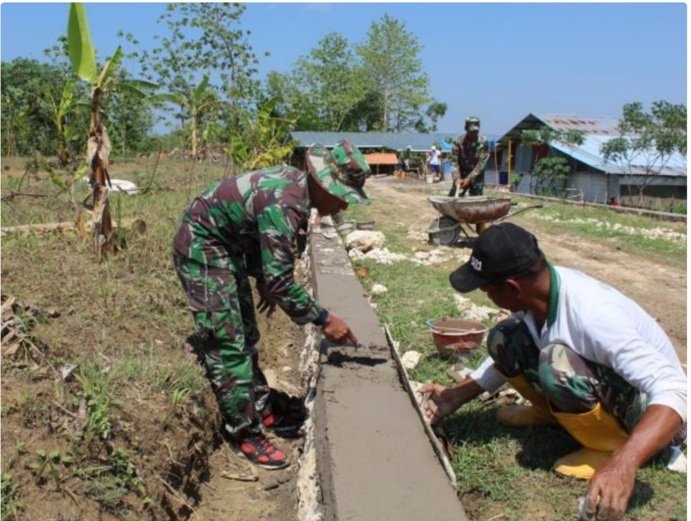
*Foto: Satgas TMMMD 112 Kodim 0721/Blora Tengah Mengerjakan Pembangunan Talud Bahu Jalan, Rabu (23/10/2024).*
